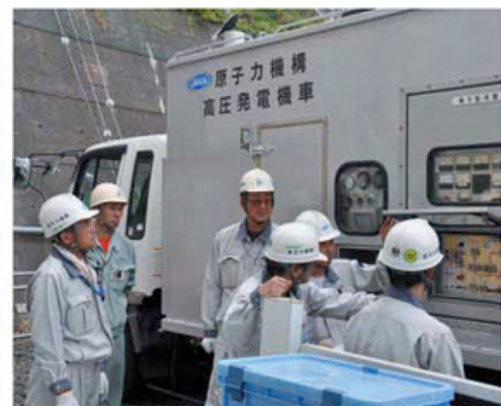
●電源車つなぎこみ訓練
