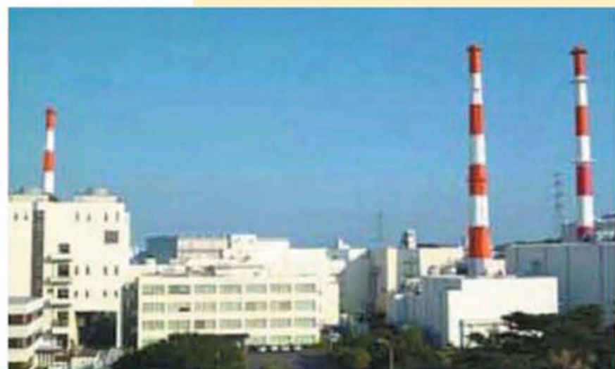
●東海再処理施設の外観
